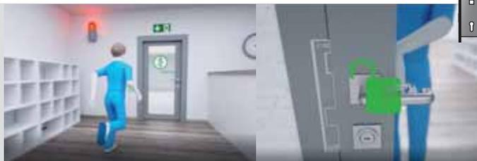
Im Falle einer Panik wird die Tür von innen durch Betätigung des Drückers oder Panikbeschlags entriegelt um den Durchgang zu ermöglichen.
