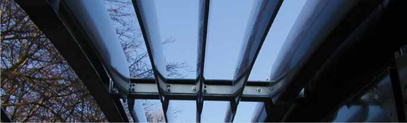
Sonderkonstruktionen: Verdeckte Befestigung, gebogen, bewegliches Parallelogramm/Special constructions: Concealed fastening, curved, parallelogram moveable
