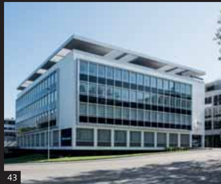
Zuger Kantonalbank Zug/Switzerland
