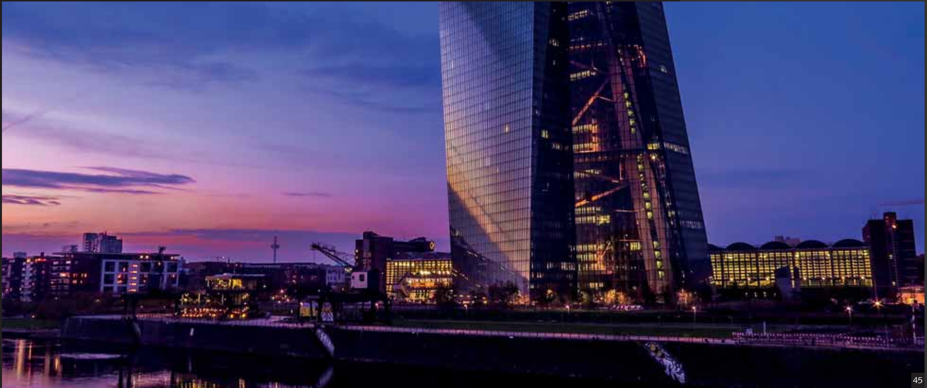
Europäische Zentralbank (EZB), Frankfurt Main/Germany
